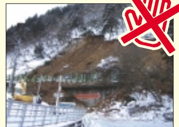
土砂崩壊で地域が孤立
